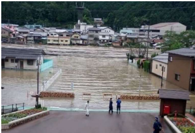
図1※ 令和2年7月豪雨被害状況
